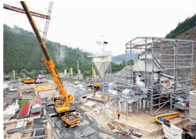
Anlage im Bau
