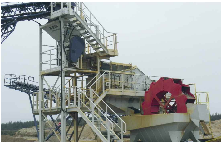
Anlage zur Nassaufbereitung
